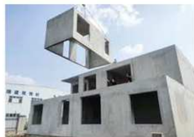
Na bázi železobetonu
